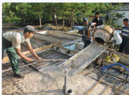
Кустарное приготовление бетонной смеси — надёжный способ получить бетон с непрогнозируемыми характеристиками.
