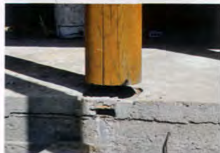
Нижнее расположение компенсатора усадки.
