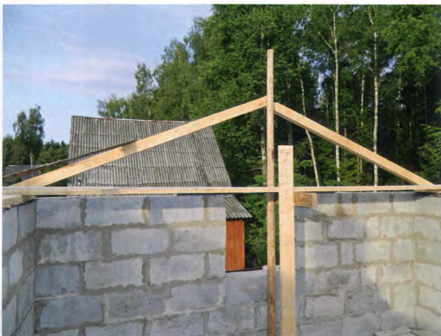
Первыми установили стропила по торцам гаража. Они послужат ориентиром при монтаже промежуточных стропил и кладке фронтонов из блоков. В коньке стропила сечением 100 × 100 мм связаны болтом М10.
