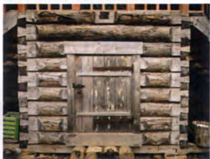
Угловое соединение брёвен «в лапу» («ласточкин хвост»).
