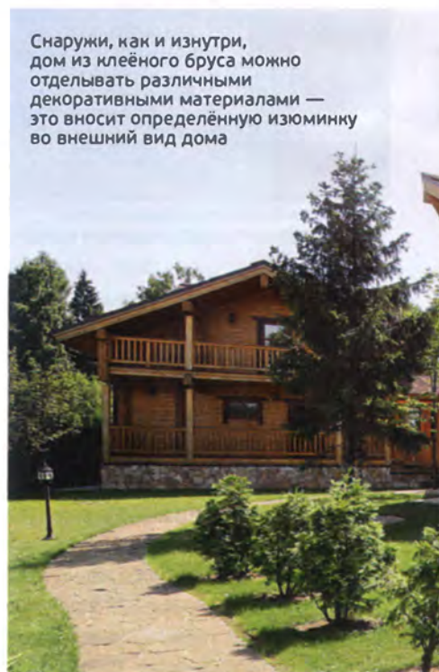
Дом из клеёного бруса — это дом высокой индустриальной готовности. В нём не стоит останавливать процесс строительства на каком-либо промежуточном этапе.
