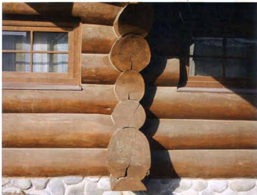
Типичные ошибки — отсутствие гидроизоляции, «тёплой» подкладной доски под окладным венцом и отсечки от брызг.
