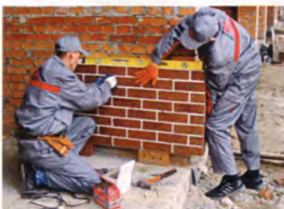
Установка стартовых элементов задаёт внешний вид всего фасада. От угла ведут первый ряд панелей, контролируя их горизонтальность.
