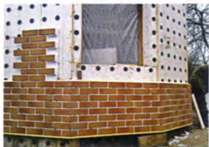
Кромку панелей надо подрезать аккуратно, сохраняя вертикальность линии угла.
