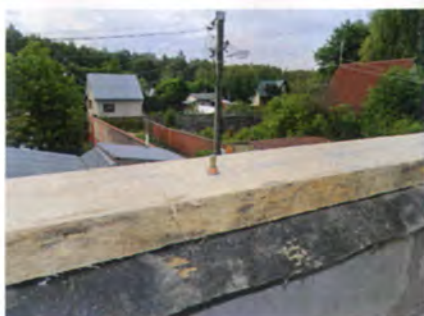
На высоте 4 400 мм на стене уложили мауэрлат, закреплённый анкерными болтами.
