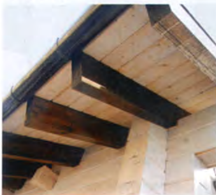
Большие выносы кровли и водосточные системы увеличивают срок службы деревянного дома.
