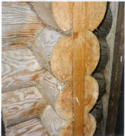
Крепление брусков окосячки в паз должно быть практически без зазоров. Нельзя жёстко закреплять бруски гвоздями к брёвнам.
