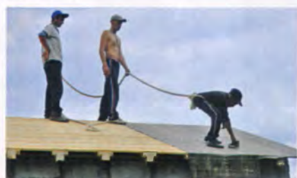
Сплошную обрешётку крыши выполнили из досок сечением 25 × 120 мм. На настил постелили рубероид в два слоя.
