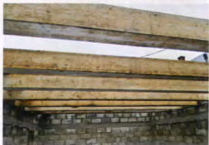
Такие балки перекрытия легко выдержат нагрузку второго этажа.
