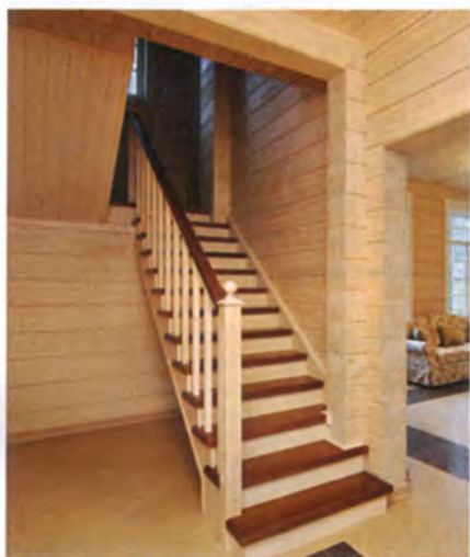
Лестницу можно монтировать после сборки теплового контура дома и кровли.
