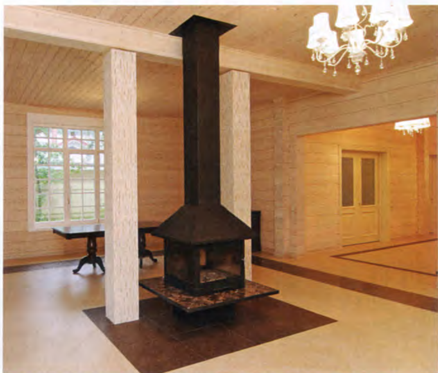
Надёжные клеёные балки длиной до 13,5 м дают возможность делать открытые интерьеры большой площади.
