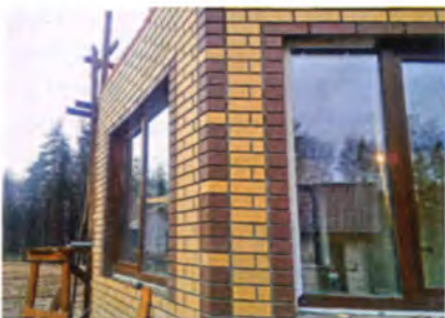
На нестандартных элементах фасада стыки панелей заделывают герметиком, а швы — затиркой.
