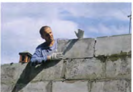
Пенобетонные блоки имеют стабильные геометрические размеры, толщина клеевого слоя составляет 6–8 мм.
