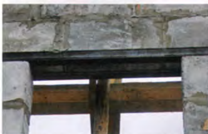
Для укладки блоков над проёмом использовали стальные уголки, поэтому блоки пришлось подпилить.
