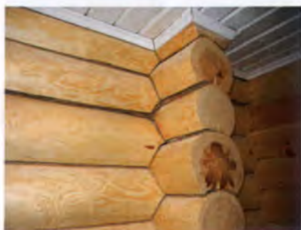
Межвенцовые зазоры в норме не должны превышать величину в 1 мм.
