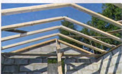
Промежуточные стропила установлены с промежутками 500 мм.
