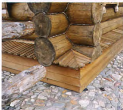
Выступающие козырьки защищают сруб от отражённых от земли брызг осадков.
