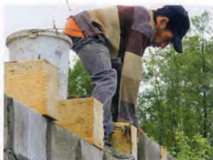
Пространство между балками перекрытия заложил пескоцементными блоками.
