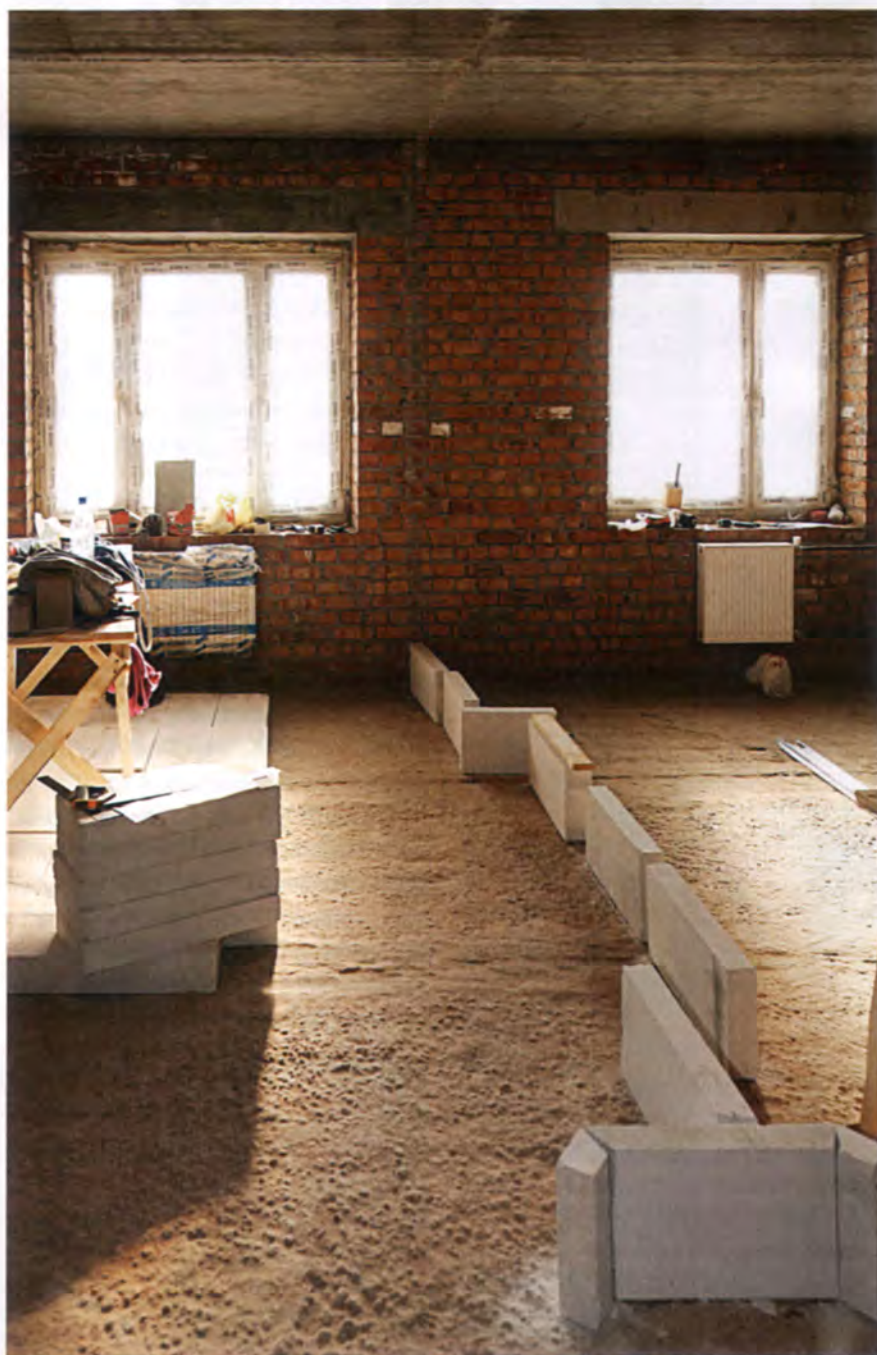
На выравнивании кирпичных стен теряется большая площадь: мы не досчитались 20 см на ширине двух комнат (около 6 м). Планируйте расстановку мебели с запасом, чистовые размеры комнат могут сильно отличаться от черновых.
