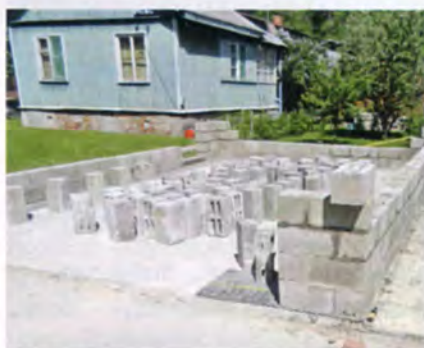
Отмостка залита и уложены первые ряды блоков.
