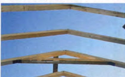
Ригели из бруса сечением 100 × 100 мм крепили к стропилам уголками.
