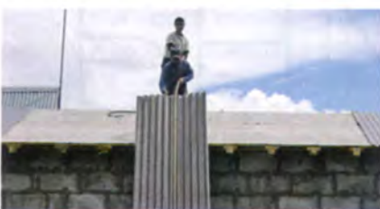
В качестве основного покрытия крыши использовали профлист С21 с рабочей шириной 1 050 мм.
