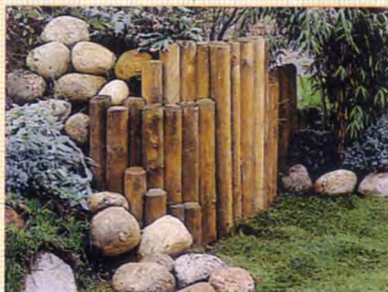
На крутых склонах брёвнышки подпорных стенок следует заглублять довольно сильно (80–90 см), чтобы нагрузка от камней и грунта не сдвинула подпорную стену. Иногда брёвнышки лучше выставить в два, а то и в три ряда.
