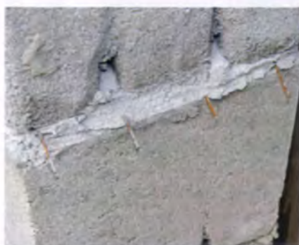
Арматурную сетку прокладывали через каждые два ряда блоков, а в проёмах рядом с проёмом для ворот и над воротами — через каждый ряд.
