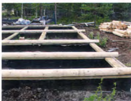
Подкладную антисептированную доску укладывают по слою гидроизоляции из современных битумно-полимерных материалов.
