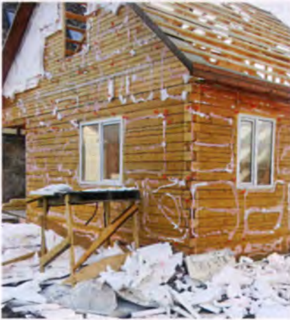
Верный способ быстро избавиться от деревянного дома — утеплить его снаружи паронепроницаемым утеплителем.
