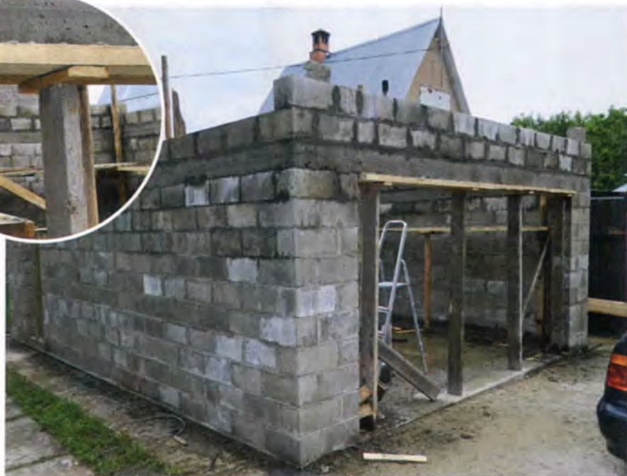
На высоте 2 000 мм сделан сплошной армопояс, и высота кладки доведена до 2 400 мм. Видны обрезки вязальной проволоки, скреплявшей боковые щиты опалубки.
