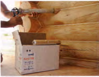
Нанесение межвенцового герметика.
