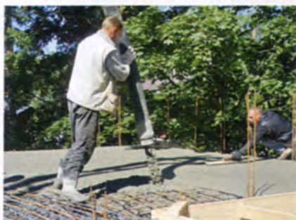
Большие объёмы смеси невозможно качественно уложить без применения товарного бетона, доставляемого в бетононасосах с бетононасосом.
