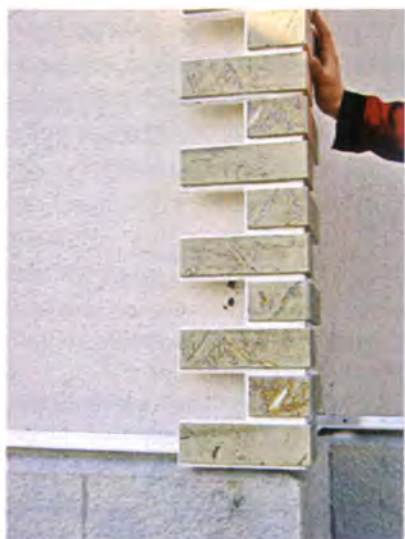
Работы по облицовке стен термопанелями начинают с угла.
