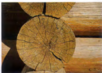
Недопустимы боковые трещины, проникающие на глубину более 1/5 диаметра торца бревна.
