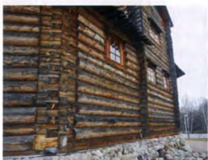
Брёвна, не очищенные полностью от луба, представляют собой лакомую среду для грибов и насекомых.
