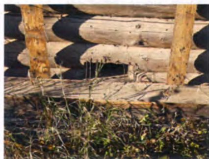
Чем ближе к земле расположены венцы, тем быстрее они подвергнутся биологическому разрушению.
