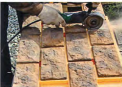
Панели режут с наружной стороны — там, где расположен облицовочный материал. Пропилить утеплитель можно ножовкой.
